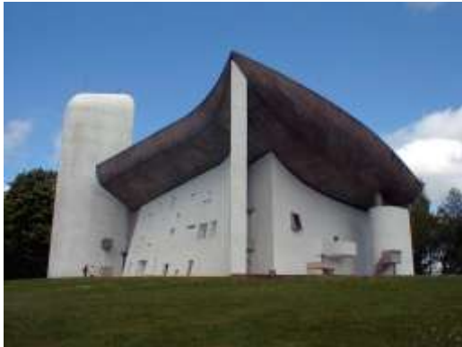
Fachada sudeste da Igreja assimétrica de Ronchamp (França), apresentando a torre em forma de silo e a cobertura curva em concreto armado aparente.
