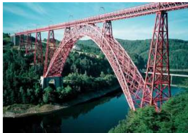
VIADUC DE GARABIT (1880/84, RUYNES-EM-MARGERIDE, FRANÇA)
